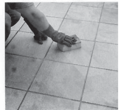
Zebrać zaprawę gąbką wiskozową
