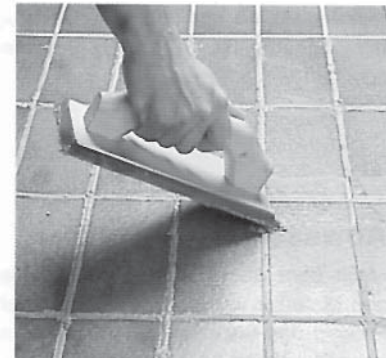
Usuwanie resztek kielnią
