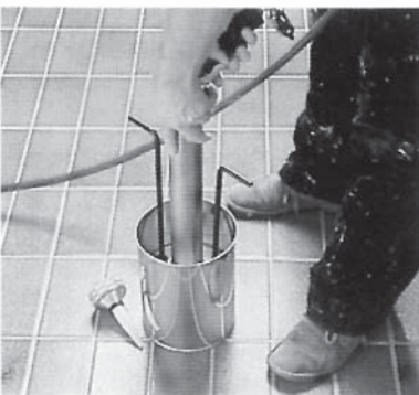
Wypełnianie fug pistoletem
