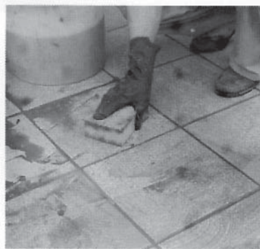
Emulgowanie twardą gąbką lub uchwytem z padzikiem
